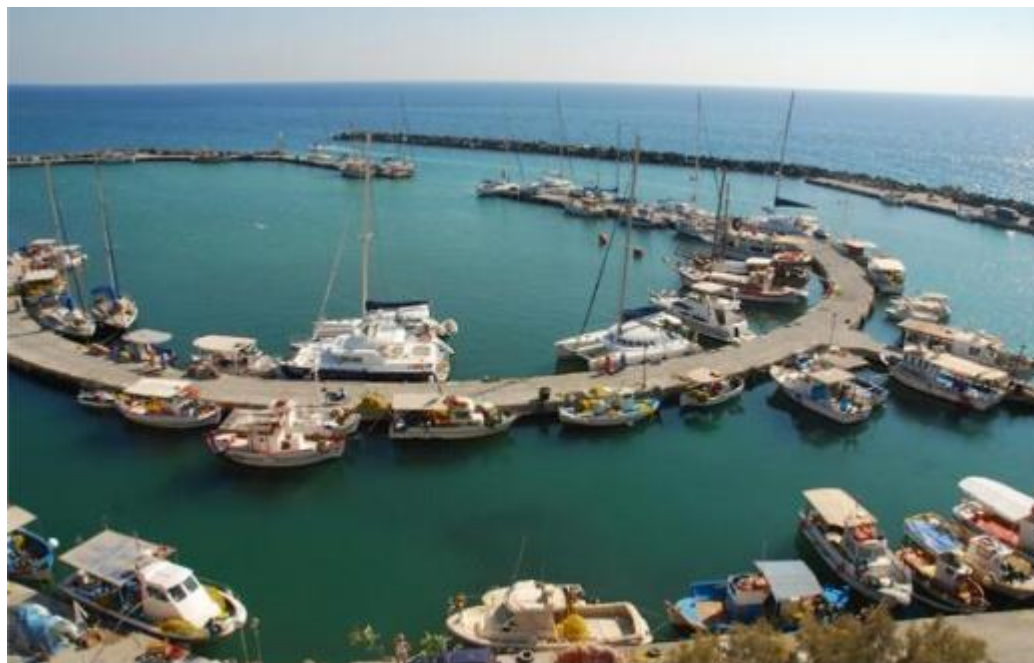
Εικόνα 4: Αλιευτικό Καταφύγιο Βλυχάδας, ν. Θήρας
